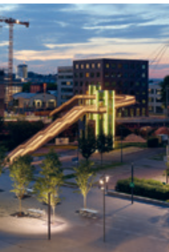
Setzt architektonische Akzente: Die Campusbrücke überquert die Bahnstrecke zum Hauptbahnhof und verbindet die beidseits der Gleise gelegenen Bereiche des Bildungscampus.
